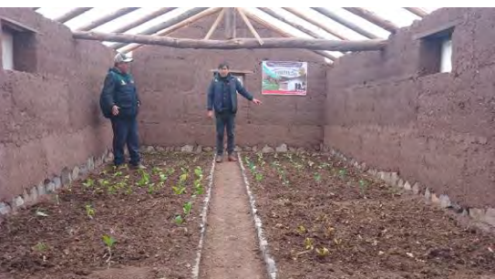
Instalación de módulos de Fito toldos
